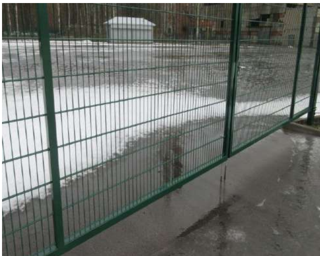
noliktavas asfalta laukums 004
