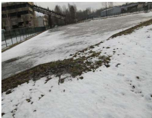
noliktavas asfalta laukums 004
