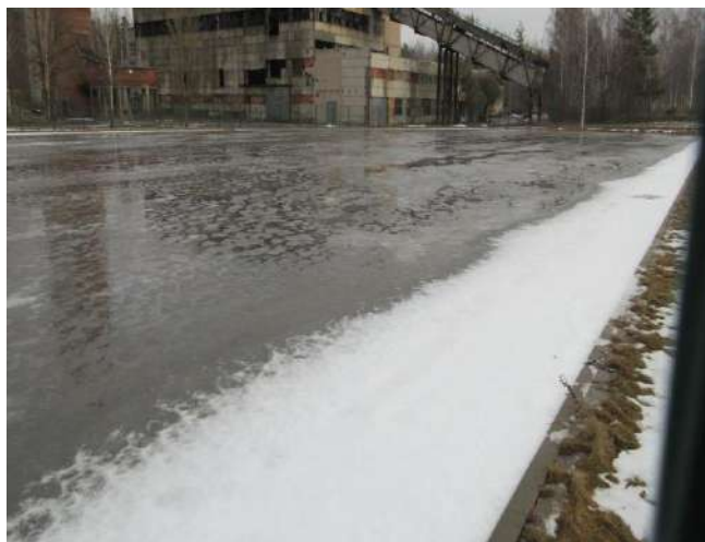
noliktavas asfalta laukums 004
