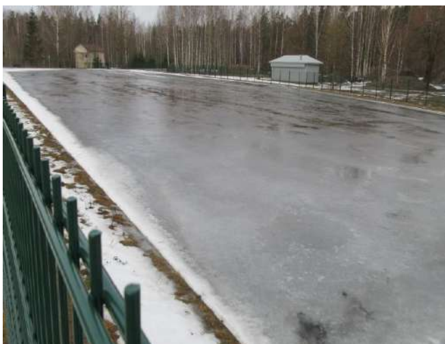
noliktavas asfalta laukums 004
