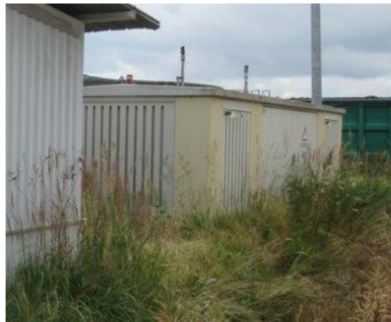
Transformatora apakšstacija (kadastra apzīmējums 76860060105013)
