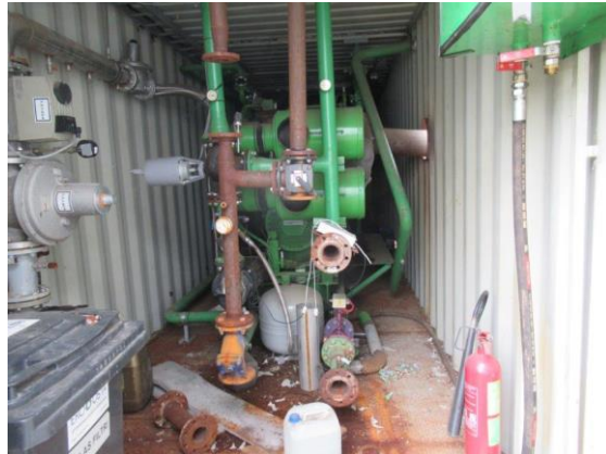
Biogāzes ražotnes koģenerācijas stacijas konteiners (kadastra apzīmējums 76860060105015) un tā iekšskats
