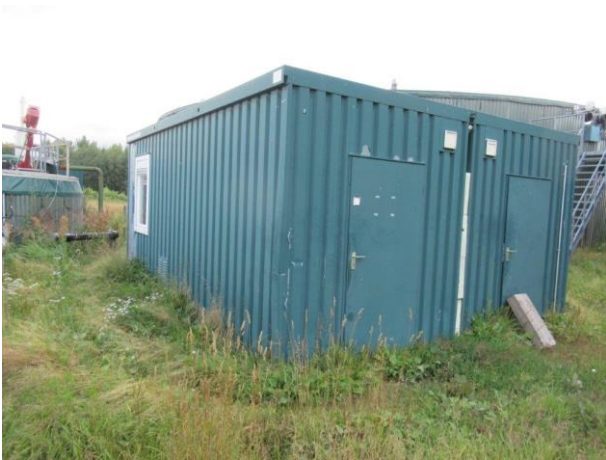
Substrāta sadales un kontroles konteiners (kadastra apzīmējums 76860060105010)
