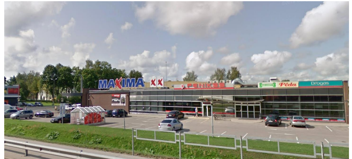
Esoša azartspēļu zāle Līvānos Domes ielā 4a, skats no Rīgas ielas (SIA “Alfor”)
