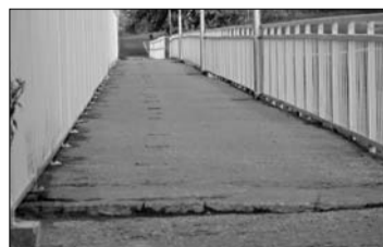
Приветливые жители заметили, что велодорожка, где установлен соответствующий знак, для велосипедистов неособенно подходит из-за разницы высоты. Сейчас проходит закупочная процедура для возобновления покрытия пешеходного моста.
