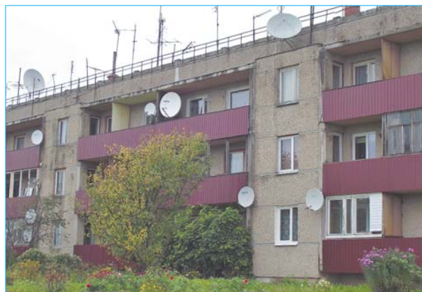
Jaunsilavās aktīvie trīsstāvu mājas (Nr.7) iedzīvotāji šogad uzrakstīja pieteikumu un saņēma naudu, lai sakārtotu 27 dzīvokļu mājas balkonu fasādes. Māja celta 1986.gadā. Veco, nolupušo un sapuvušo balkonu vietā tagad priecē skaists metāla seguma balkonu apdares materiāls bordo krāsā. Koordinatore Kristīne Kīrillova.
