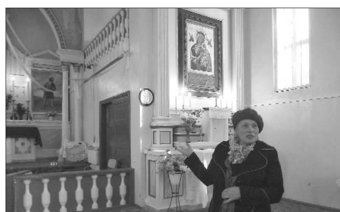
■ Проект замены электроинсталляции в Знотиньской католической церкви. Представляет его координатор Паулина Зариня.
