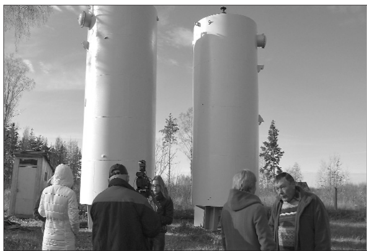
■ Эдита Ильина, руководитель садоводческого общества "Biokimikis" – написала проект, чтобы при помощи финансирования думы покрасить баки водоснабжения, которые снабжают водой примерно 100 пригородных дачных участков и район жилых домов в "Dubnas viensētās", Туркской волости.
