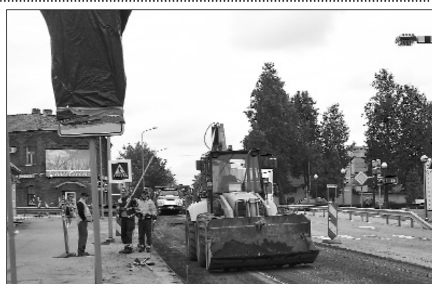
■ Летний сезон последних лет для многих в памяти останется с объемными строительными работами на центральной улице и регулируемым светофорами автодвижением.
