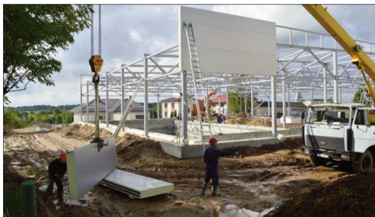
■ Līvānu peldbaseina sienas paneļu montāžas darbi
