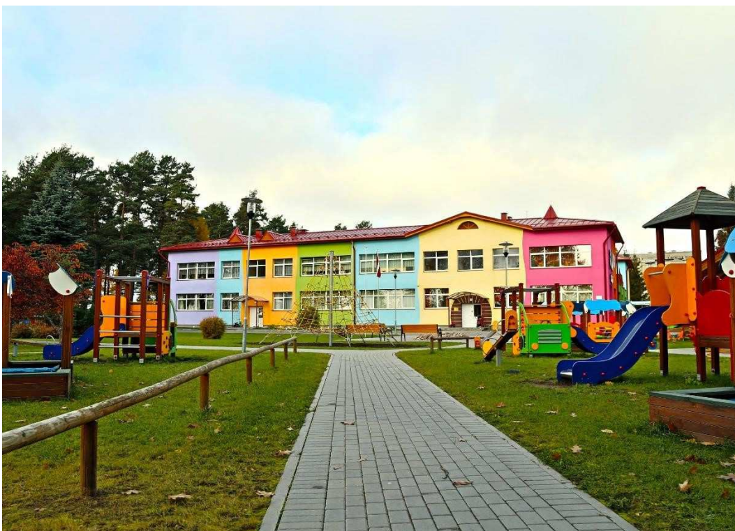
33.att. PII „Rūķīši” Rīgas ielā 13 (foto: Jānis Magdaļenoks)
