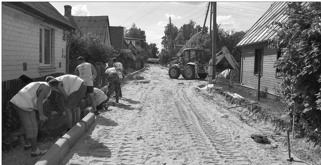
■ Улица Софияс. Строительные работы в полном разгаре
